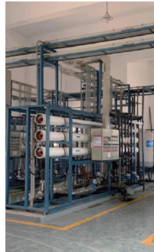
*系统回收率≥85% *系统COD去除率≥96% *产水低色度 *纳滤系统运行压力0.50Mpa *纳滤系统运行温度:30-39℃ *系统产水流量: 15t/h
