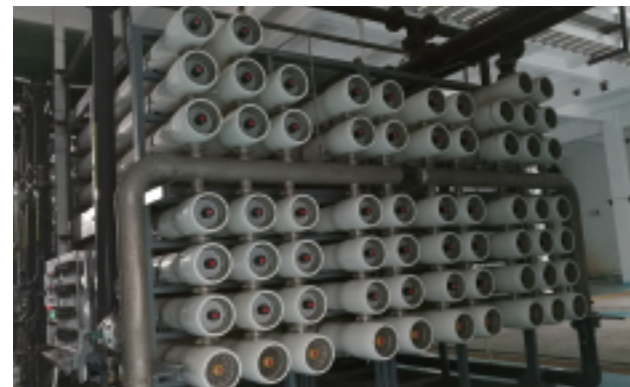
项目名称: 安徽中科 更换时间: 2015年03月 产品选型: NF/8040-R85 原水水源: 地下水 处理量: 2300 T/D
