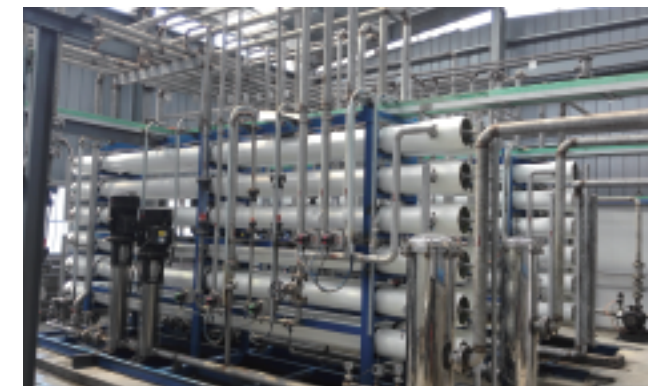
*系统回收率>96% (最高实现98%极回收率) *产水色度0 *产水满足后端RO进水要求 *纳滤系统运行压力0.48-0.80Mpa
