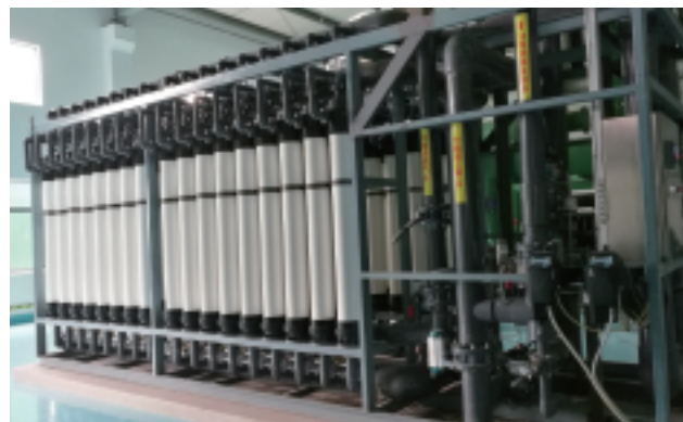
项目名称: 绍兴市如龙纺织科技有限公司 建设时间: 2018年 产品选型: EM-UF-8080-PVDF 原水水源: 印染废水 处理量: 14000T/D
