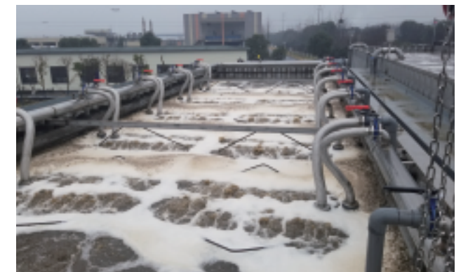
项目名称: 宜兴市应急处理设施项目 建设时间: 2020年 产品选型: MBR 处理量: 15000m 3 /d
