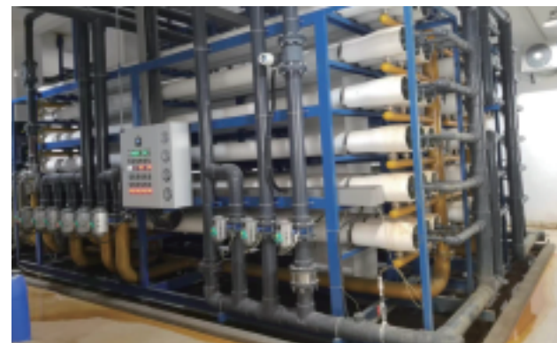
项目名称: 河南龙宇煤化工 建设时间: 2019年 产品选型: BW-400FR 原水水源: 工业废水 处理量: 5200T/D
