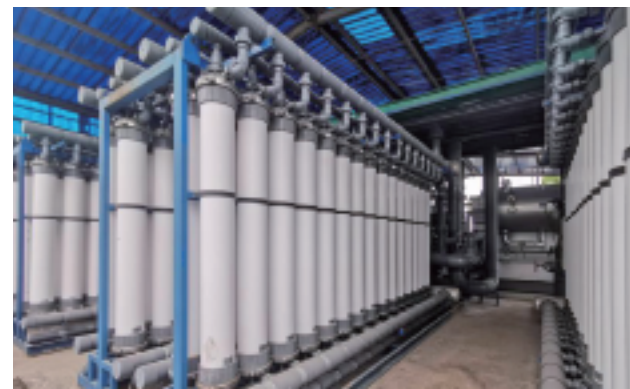
项目名称: 杭州得力纺织有限公司 建设时间: 2013年 产品选型: EM-UF-8080-PVDF 原水水源: 工业废水 处理量: 9000T/D
