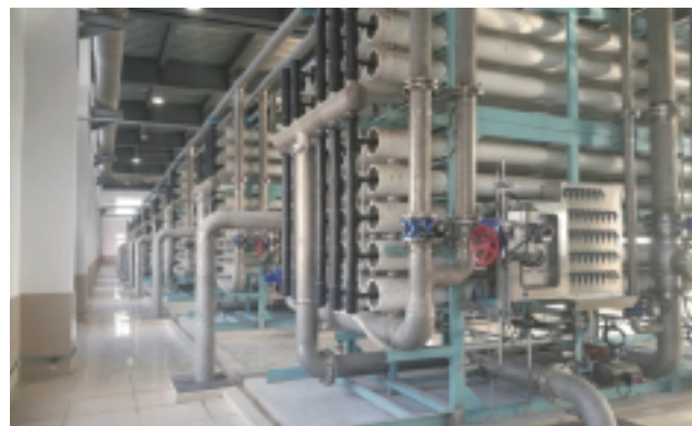
项目名称: 大丰开发区工业水厂 建设时间: 2017年12月 产品选型: EF-1 原水水源: 工业废水 处理量: 8000T/D
