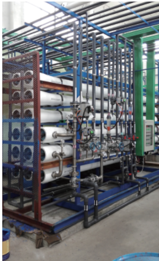
项目名称: 江苏某农药企业母液回收 建设时间: 2019年 产品选型: NF-8040 处理量: 400T/D
