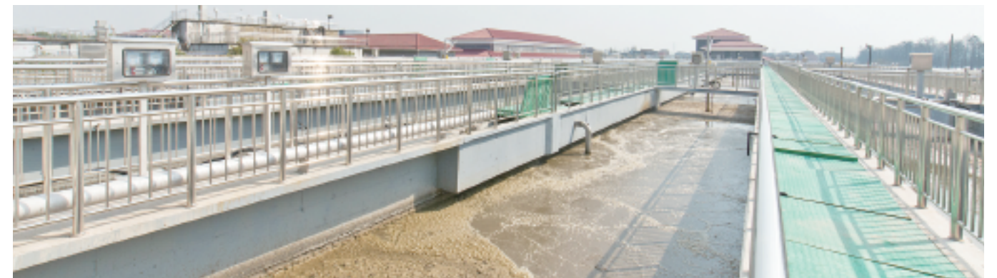
项目名称: 良渚污水处理厂三期MBR系统(3万m 3 /d)工程EPC 建设时间: 2015年 产品选型: MBR 处理量: 30000m 3 /d
