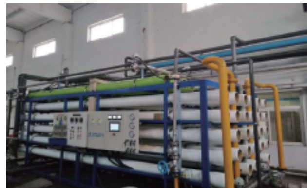
项目名称: 山东国润 建设时间: 2015年08月 产品选型: NF/8040-R85 原水水源: 循环水污水混兑反渗透浓水 处理量: 2000T/D
